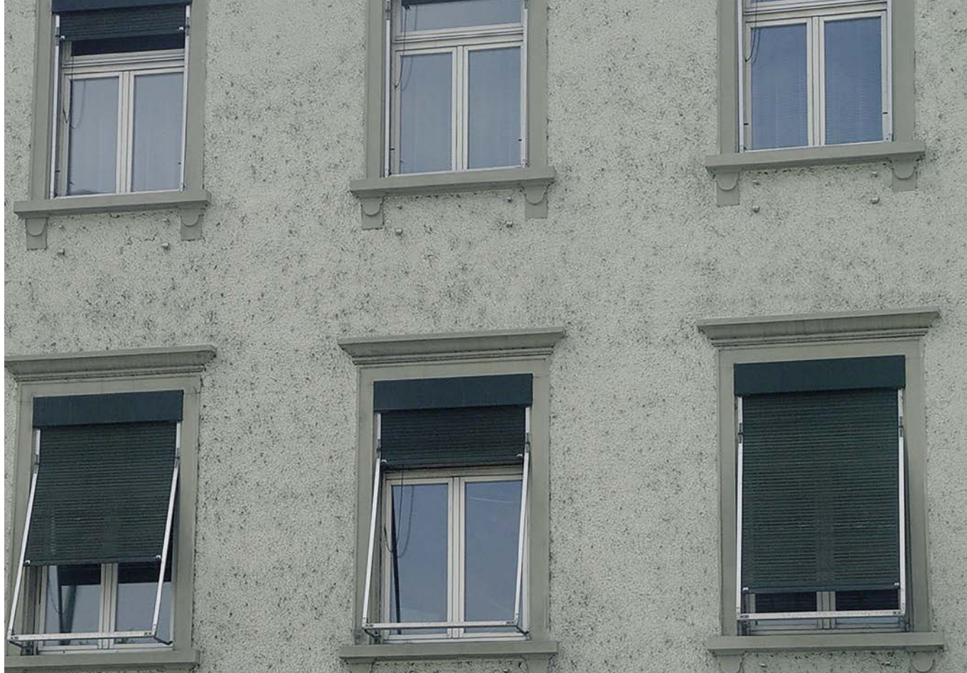
Illustration 2 Façade avec toiles d'araignées (taches foncées)
