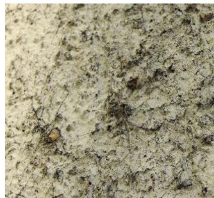
Enduit à structure grossière
