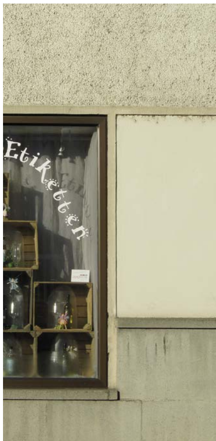
Même système de couleurs sur différentes structures d'enduit
